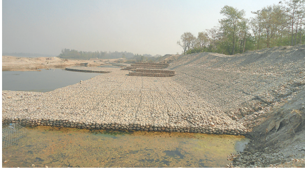
बबईको राजापुरस्थित कर्णाली नदीमा निर्माणधीन तटबन्ध ।
