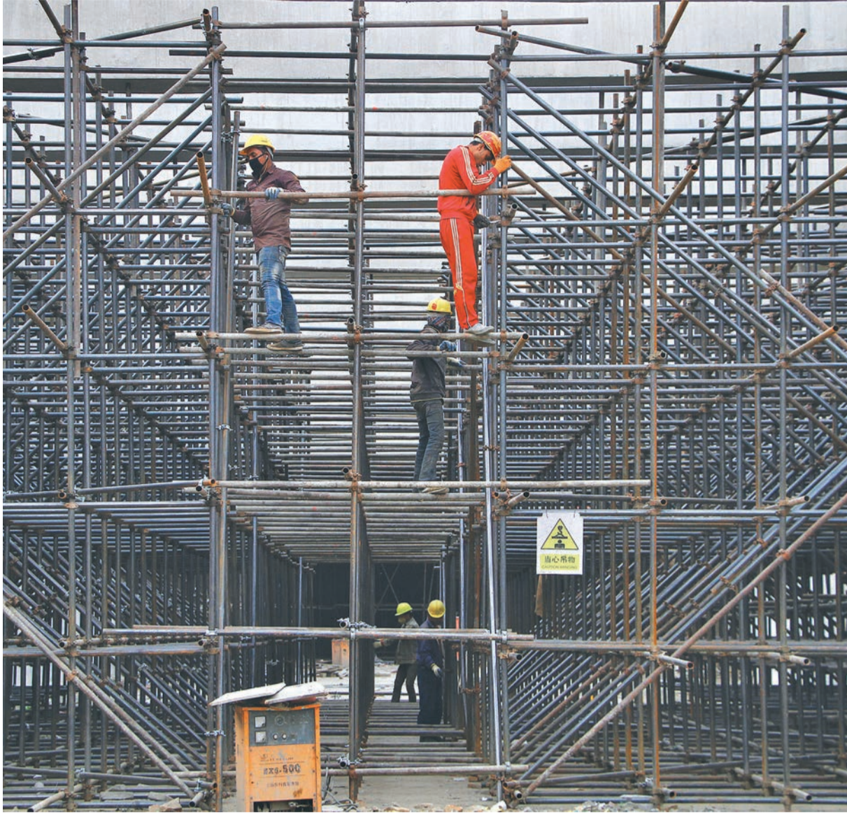
राजधानीको कलंक्रीमा बनाउँदै गरिएको सुरङ (अन्डरपास) मा काम गर्दै मजदुरहरू । आगामी पाँच महिनामा सुरङको निर्माण कार्य सम्पन्न गर्ने गरी काम भइरहेको छ ।
