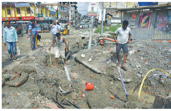
नाला निर्माणका क्रममा डोजरले विराटनगरको महेन्द्र चोक पूर्वतर्फ नेपाल टेलिकमको भूमिगत तार काटेपछि मर्मत गर्दै टेलिकमका प्राविधिक । तस्विर : विन्नु कान्तिपुर
