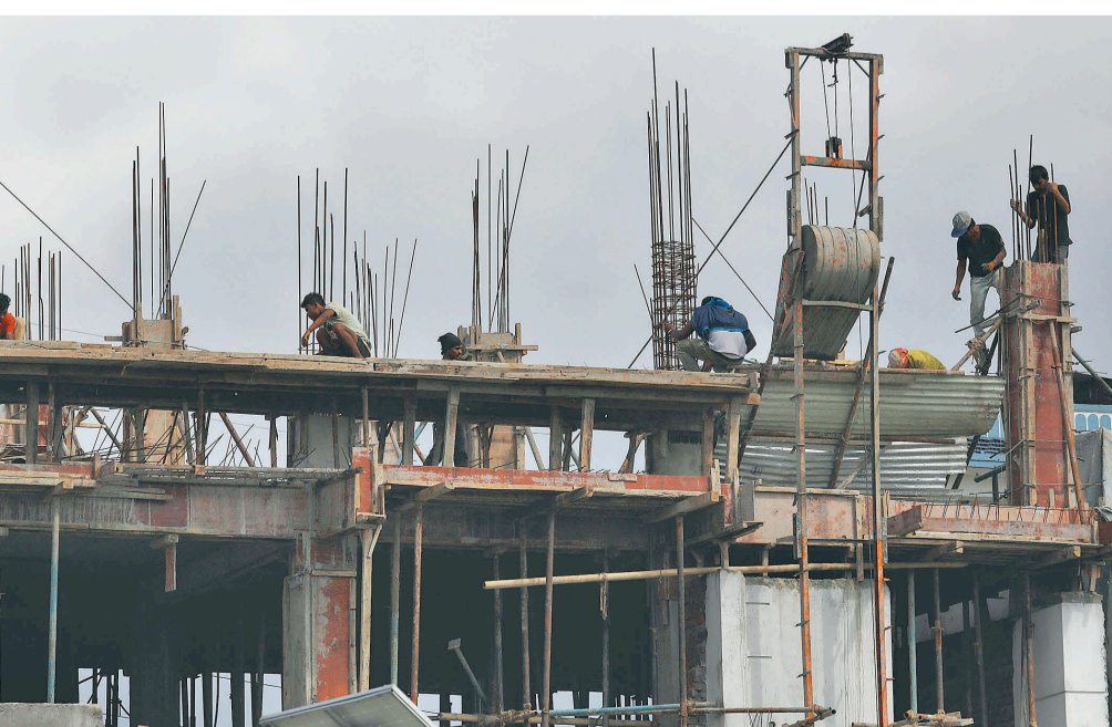
ललितपुरको शंभुमूला बुधवार निर्माणाधीन घरमा ढलानको काम गर्दै कामदारहरू।
