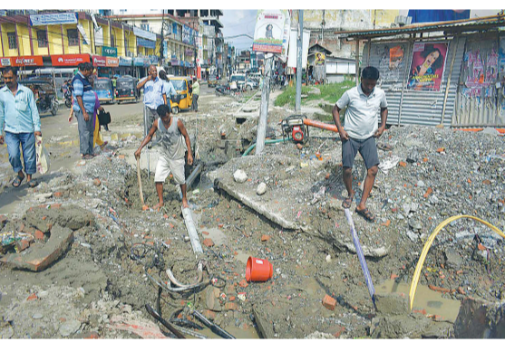
नाला निर्माणका क्रममा डोजरले विराटनगरको महेन्द्र चोक पूर्वतर्फ नेपाल टेलिकमको भूमिगत तार काटेपछि मर्मत गर्दै टेलिकमका प्राविधिक । तस्विर : विन् / कान्तिपुर
