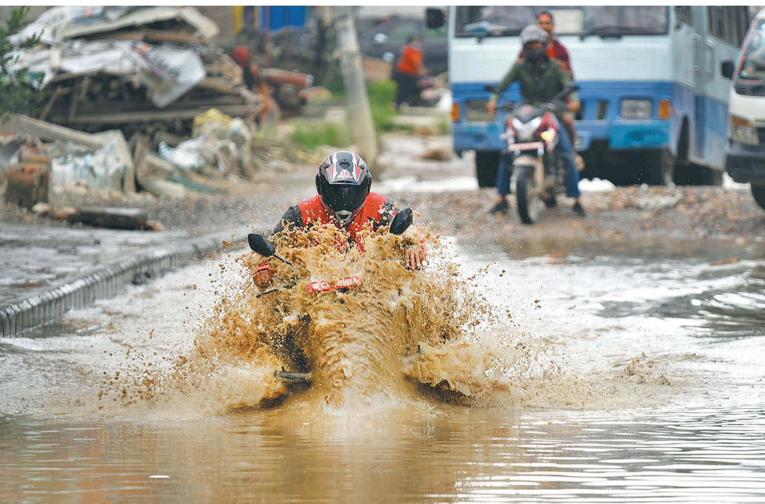
भक्तपुरको निकोसोरा सडक ढाडमा जमेको पानीबाट जोखिम मोलेर मोटरसाइकल चलाउँदै । यहाँ खाल्डो यति ठूलो भइसक्यो कि साना सवारीसाधन वारपार गर्नु धौधौ हुन्छ । सडक मर्मत गर्न नगरपालिका, सडक विभाग, खानेपानी विभाग र जनप्रतिनिधिलाई पटक-पटक अप्ठ्यारो पर्ने सुनुवाइ नभएको स्थानीयको गुनासो छ ।
