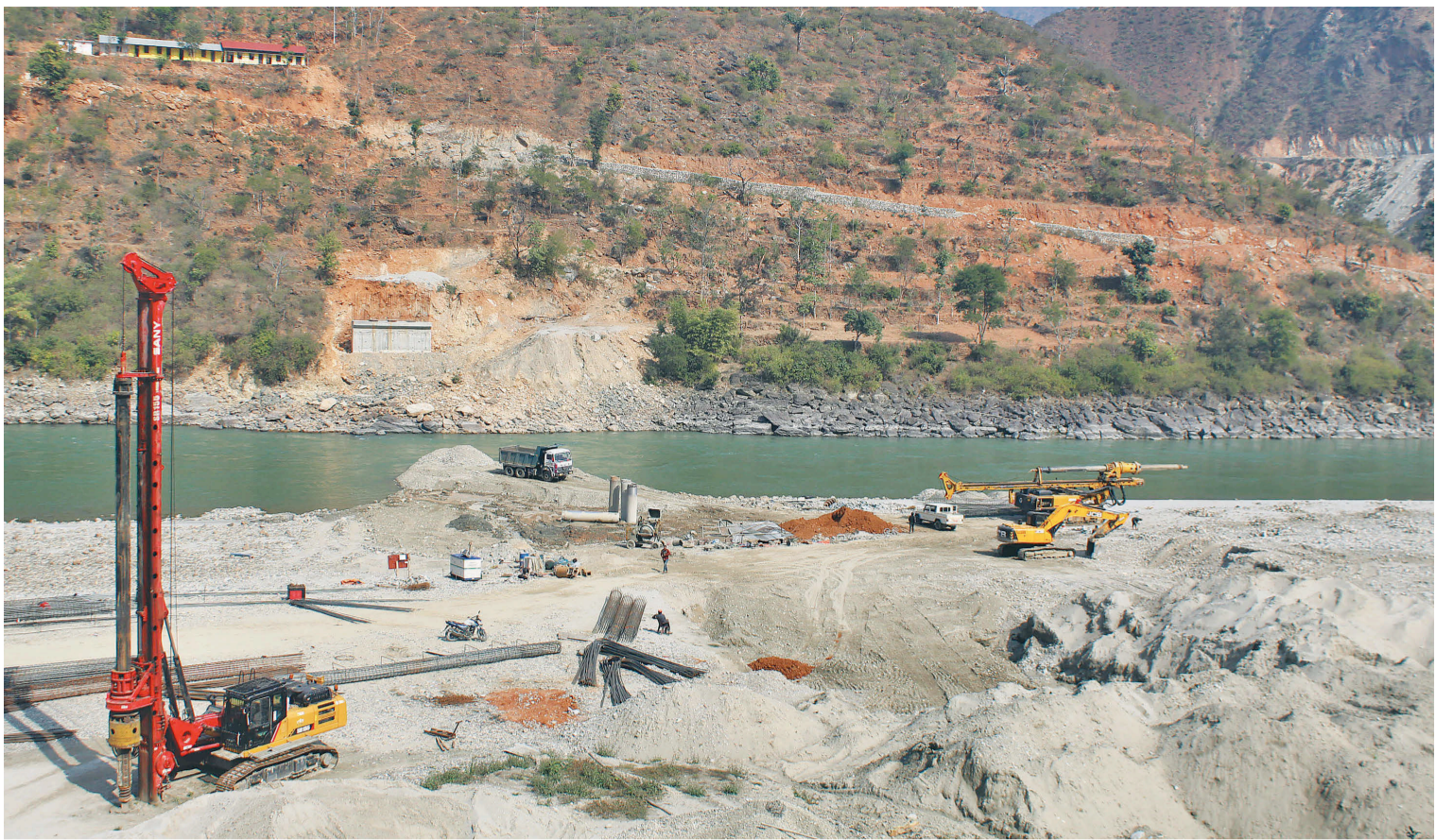
मध्यपहाडी लोकमार्गाअन्तर्गत सिन्धुलीको गोलन्जोर गाउँपालिकाको तवलपुरबाट रामेछाप जोड्ने निर्माणधीन सुनकोसी पुल। यही पुलभन्दा करिव दुई किमिअगाडि ओखलढुंगा जोड्ने अर्को पुल बनिरहेको छ।
