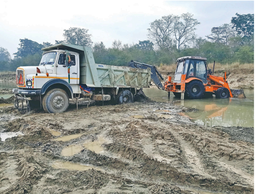
कञ्चनपुरको लालभाडी गाउँपालिकाको मछेली खोलामा एस्काभेटरद्वारा भइरहेको उत्खनन ।
