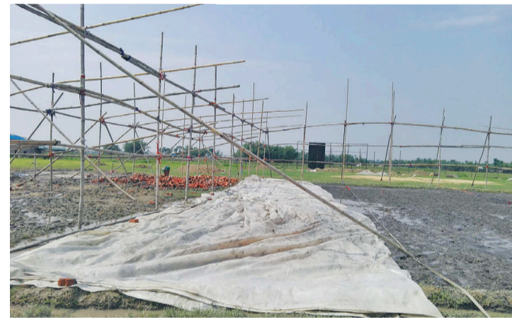
बैजनाथपुर रंगशालाको जमिनमुनि गाडिएको ३५ हजार ५ सय ईटामाथि माटो भरेर ६ वटा टर्फ विकेटमा काम गरिँदै। तस्वीर : विनोद/कान्तिपुर
