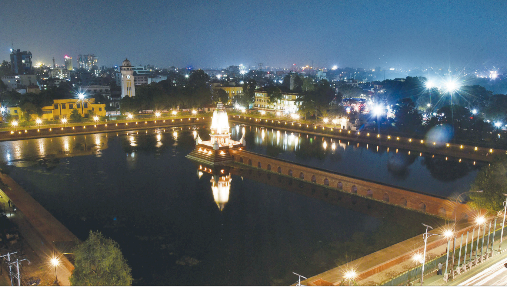
बिजुलीको प्रकाशमा मोहक देखिएको काठमाडौंको रानीपोखरी क्षेत्र शुक्रबार साँझ। २०७२ को भूकम्पले क्षतिग्रस्त रानीपोखरी र यसको बीचमा रहेको बालगोपालेश्वर मन्दिर पुनर्निर्माण हालै सकिएको हो। पानी ल्याएर पोखरी पनि भरिएको छ। बसेन भाइटीकाको दिनमात्र प्रवेश खुला गरिने मन्दिरमा भूकम्पयताका पाँच वर्ष सर्वसाधारण जान पाएका छन्।
