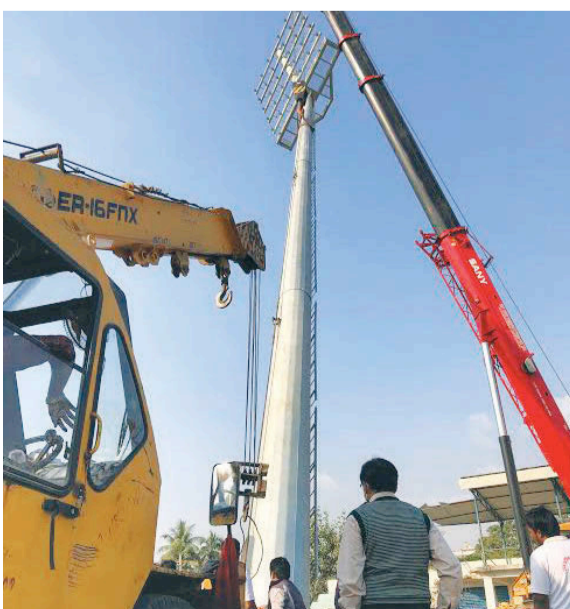
विराटनगरको सहिद मैदानमा फ्लडलाइट जडान गरिँदै । मैदानको चारै कुनामा ३० मिटर अग्लो माक्समा हजार वाटका २७ वटा बत्ती जडान गरिनेछ ।
