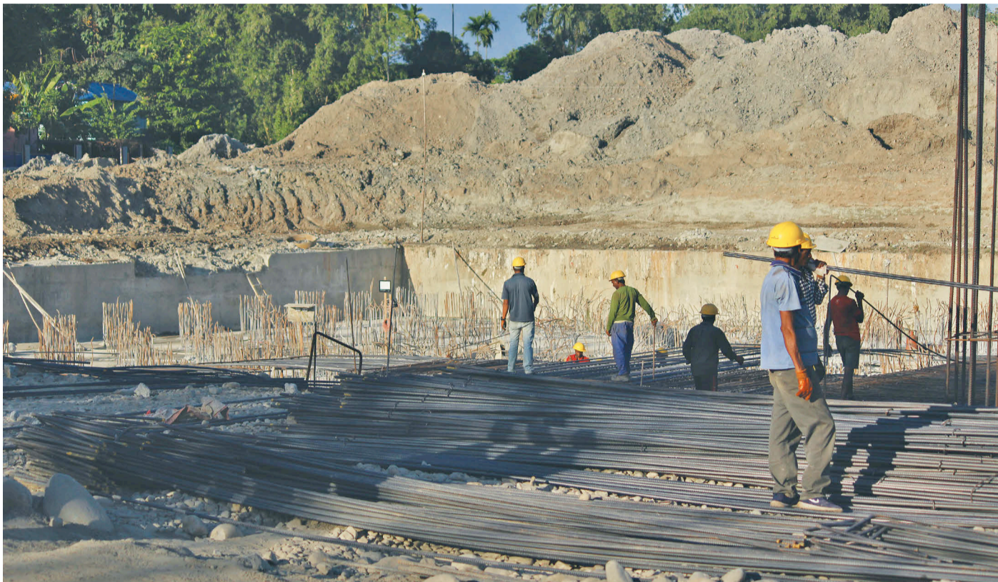
प्रधानमन्त्री केपी शर्मा ओलीको गृहजिल्ला भन्नाको दमकमा निर्माणाधीन भ्यू टावर। शिलान्यास भएको चार वर्ष हुँदा यसको प्रगति २५ प्रतिशत मात्र छ। भ्यू टावर निर्माण भने २०७९ पुससम्म सक्नुपर्नेछ।
