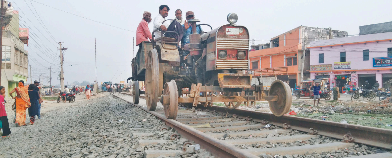
जनकपुर-कुर्था खण्डको सीता चोकमा शनिबार लिकमा ट्र्याक्टर । टायर भिक्नेर फलामको पांघा जोडेर लिकमा कडाइएको ट्र्याक्टरले जयनगरबाट रेल्वेको निर्माण सामग्री बोकेर ल्याएको थियो । हाल लिक निर्माण पूरा भएको जयनगर-कुर्था ३६ किलोमिटर खण्डमा रेल चलाउन सरकारले गत असोजमै दुई सेट इन्जिनसहित कोच खरिद गरेर धनुषा भित्र्याए पनि रेल सेवा सञ्चालनको मिति तोक्न सकेको छैन ।
