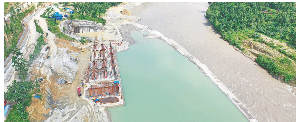
सुर्खेतको भेरीगंगा नगरपालिकाको चिप्लेखिन्धे भेरी-बबई डाइभर्सन आयोजनामा सिभिलतर्फको काम हुँदै ।
