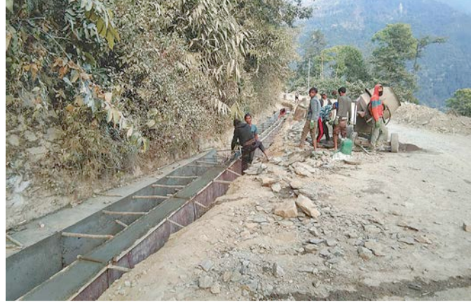
मध्यपहाडी लोकमार्गअन्तर्गत बागलुङको इटिलाभाटीमा नाली बनाइँदै। यो सडकको विहो खण्डका ठेकेदार निर्माण छोडेर भागेका छन्।
