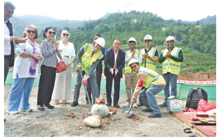
नुवाकोटको रातमाटेमा सबस्टेसन निर्माणको शिलान्यास गर्दै अर्थ मन्त्रालयका सचिव तथा एमसीए-नेपाल बोर्डका अध्यक्ष घनश्याम उपाध्याय र अमेरिकी कार्यवाहक राजदूत स्केट अब्स ।
