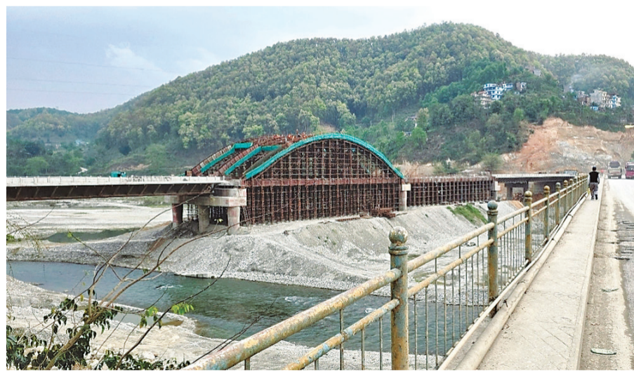
तनहुँको व्यास नगरपालिका-४ र ५ जोड्ने मादी नदीमाथि निर्माणधीन पुल। तस्बिर : सम्भरना/कान्तिपुर
