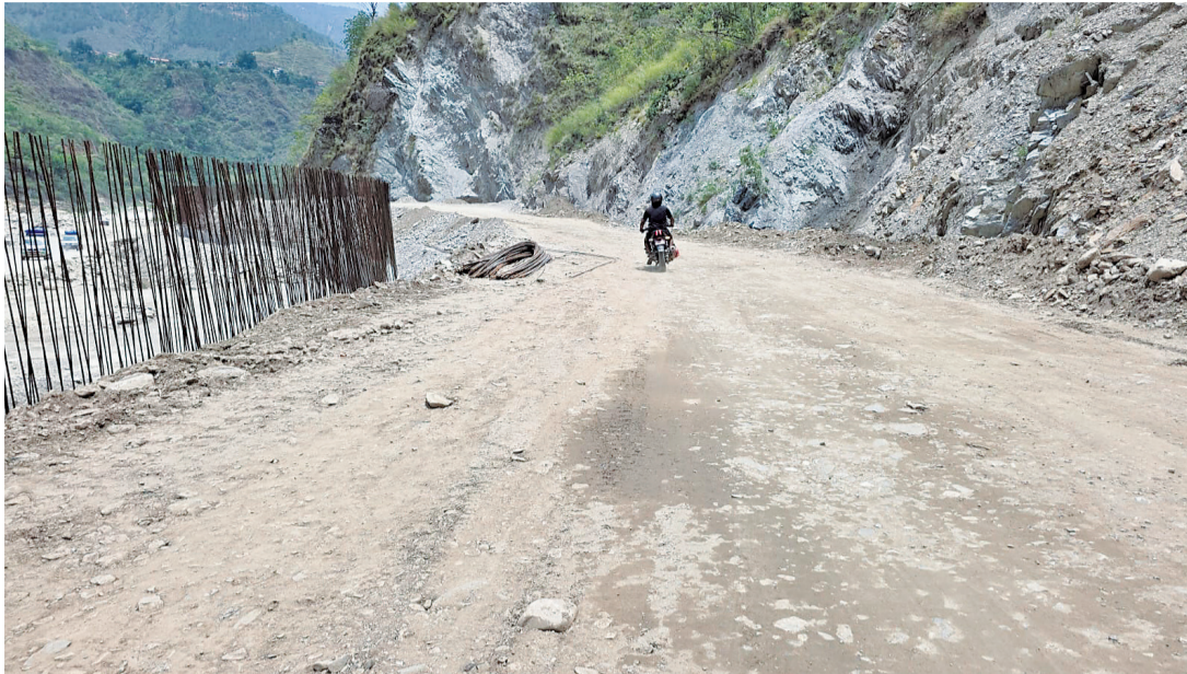
निर्माणाधीन बीपी राजमार्गको मंगलटार खण्ड।
