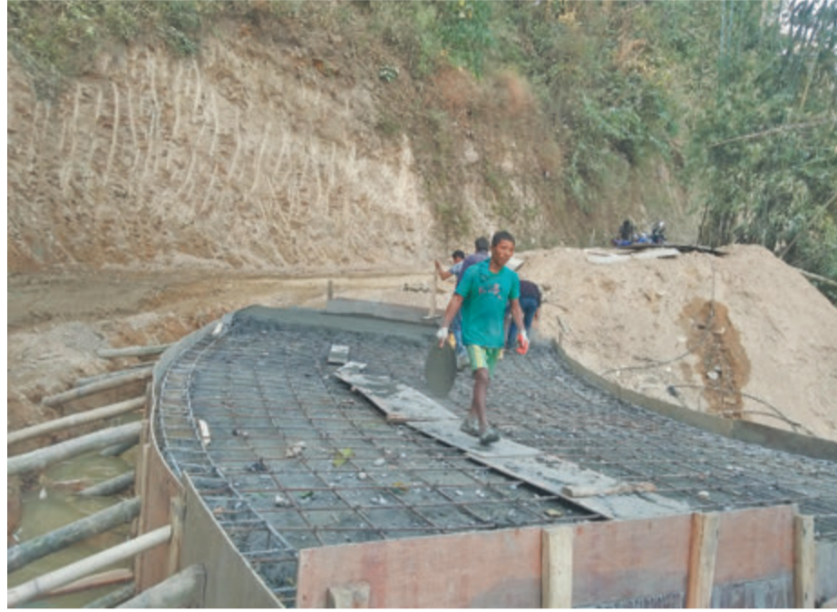
इलामको सोयाकमा सडक निर्माणमा जुटेका कामदार । डेनिस सरकारको सहयोगमा निर्माणाधीन यो सडकको काम सुस्त हुँदा समयमै पूरा नहुने देखिएको छ ।
