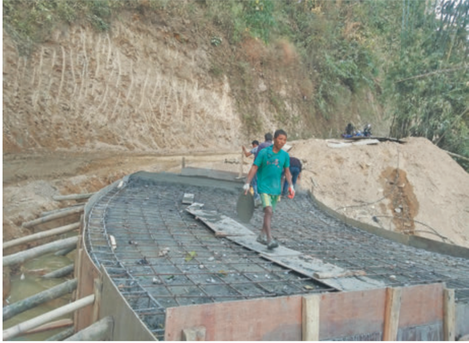
इलामको सोयाकमा सडक निर्माणमा जुटेका कामदार । डेनिस सरकारको सहयोगमा निर्माणाधीन यो सडकको काम सुस्त हुँदा समयमै पूरा नहुने देखिएको छ । तस्विर : विप्लव
