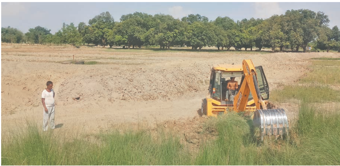
रौतहटको बृन्दावन नगरपालिकास्थित हरसाहमा निजी जग्गामा खाडल पारेर नयाँ सडक बनाउँदै ।
