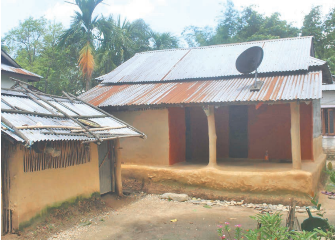
धिमाल होमस्टेका लागि ऋपाको दमक ३ मा निर्माण गरिएको धिमाल जातिको परम्परागत माटोको घर ।
