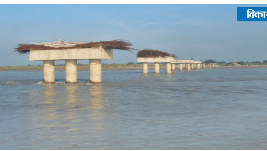
भ्रामाको हुलाकी राजमार्गअन्तर्गत कन्कार्ड नदीमा निर्माणधीन पुल । पप्पु कन्स्ट्रक्सनले ४ वर्षमा पूरा गर्नुपर्नेमा ७ वर्ष पुग्दा पनि आधा काम भएको छैन । निर्धारित समयमा पुल नबन्दा सर्वसाधारण जोखिम मोलेरै काठको डुंगामा नदी वारपार गर्न बाध्य छन् ।
