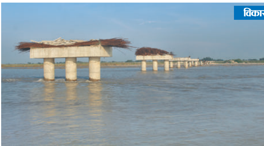
भ्रामाको हुलाकी राजमार्गअन्तर्गत कन्काई नदीमा निर्माणाधीन पुल । पप्पु कन्स्ट्रक्सनले ४ वर्षमा पूरा गर्नुपर्नेमा ७ वर्ष पुग्दा पनि आधा काम भएको छैन । निर्धारित समयमा पुल नबन्दा सबैसाधारण जोखिम मोलेरै काठको डुंगामा नदी वारपार गर्न बाध्य छन् ।
