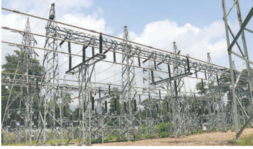
बाँकेको राप्तीपारि विद्युत् विस्तारका लागि कुसुममा निर्माण भइरहेको सबस्टेसन ।
