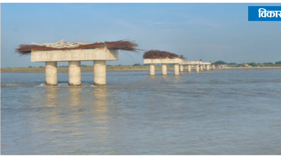
भ्रमणको हुलाकी राजमार्गअन्तर्गत कन्काई नदीमा निर्माणाधीन पुल । पप्पु कन्स्ट्रक्सनले ४ वर्षमा पूरा गर्नुपर्नेमा ७ वर्ष पुग्दा पनि आधा काम भएको छैन । निर्धारित समयमा पुल नबन्दा सर्वसाधारण जोखिम मोलेरै काठको डुंगामा नदी वारपार गर्न बाध्य छन् ।
