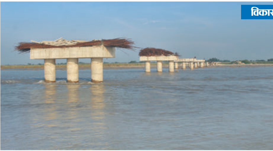
भ्रामाको हुलाकी राजमार्गअन्तर्गत कन्कार्ड नदीमा निर्माणधीन पुल । पप्पु कन्स्ट्रक्सनले ४ वर्षमा पूरा गर्नुपर्नेमा ७ वर्ष पुग्दा पनि आधा काम भएको छैन । निर्धारित समयमा पुल नबन्दा सर्वसाधारण जोखिम मोलेरै काठको डुंगामा नदी वारपार गर्न बाध्य छन् ।
